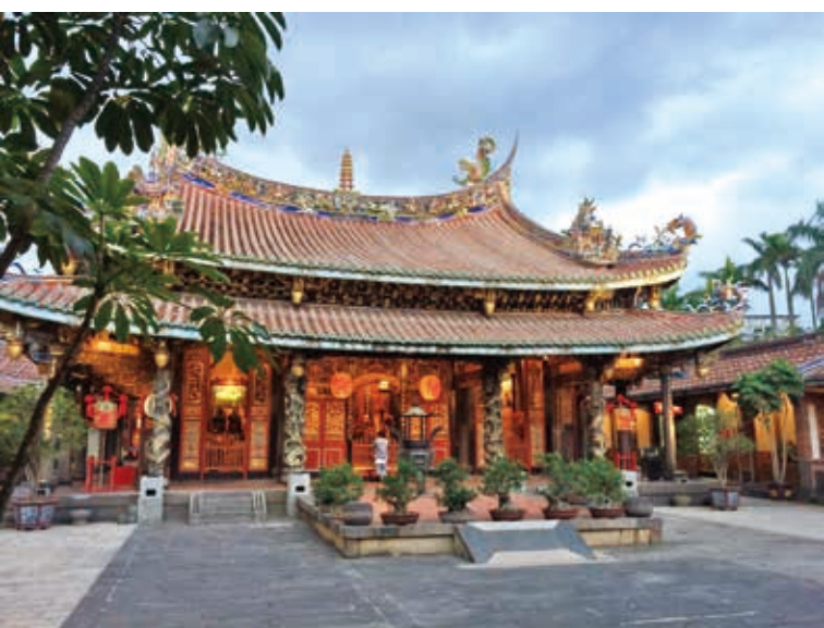
保安宮正殿於民國八十四年重修時，將正殿前遮雨棚拆除，丹墀恢復為一開間，重現原有典雅之美。
